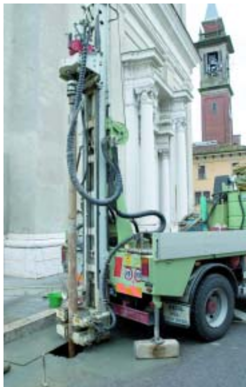
Esecuzione di un sondaggio a carotaggio continuo. La profondità del sondaggio è stata di 20 metri.
